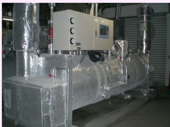
小型化、高効率化されたターボ冷凍機（左）とボイラ(右) [町田東急ツインズ]
