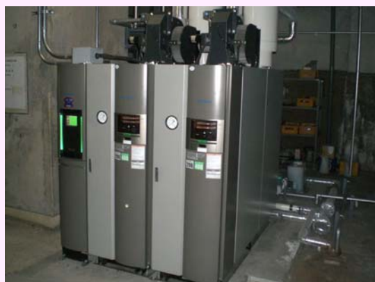
小型化、高効率化されたターボ冷凍機（左）とボイラ(右) [町田東急ツインズ]
